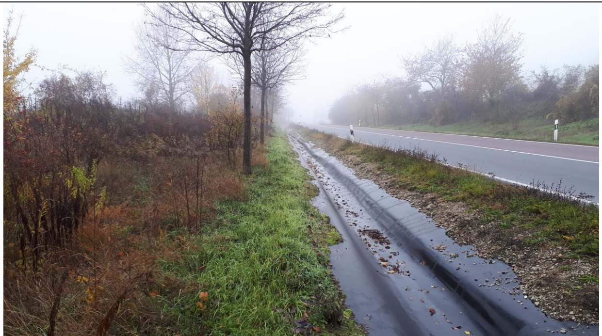
Bild 14: Um die Standsicherheit der Nordböschung des Kiessandtagebaus nicht zu gefährden, wurde der Entwässerungsgraben parallel zur Bundesstraße 176 auf der gesamten Länge des Tagebaus mit einer PE-Folie gesichert, die das Versickern von Niederschlagswässern im Graben verhindert. 22.11.2019.
