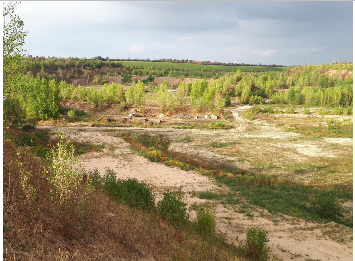
Bild 5: Blick von der Südwestböschung des Kiessandtagebaus in Richtung NNE auf den geplanten Deponieteil DK0. Hinter der Baumreihe in der Bildmitte (Zufahrtstraße) beginnt der Bereich DKI, der sich bis an die Böschungen im Hintergrund streckt. In der Bildmitte oberhalb des Hanges sind die Dächer der Ortschaft Schleberoda zu sehen. 14.09.2018
