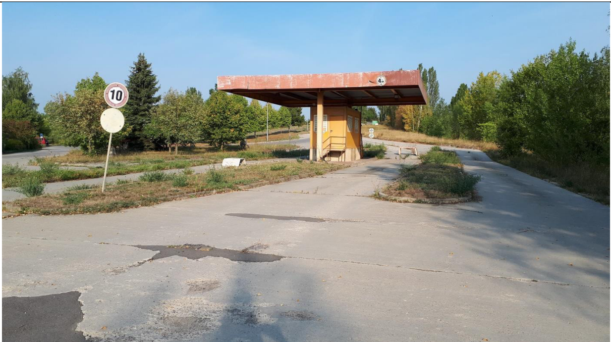
Bild 10: Blick von Süd nach Nord auf die bereits bestehende Waage. 28.08.2019
