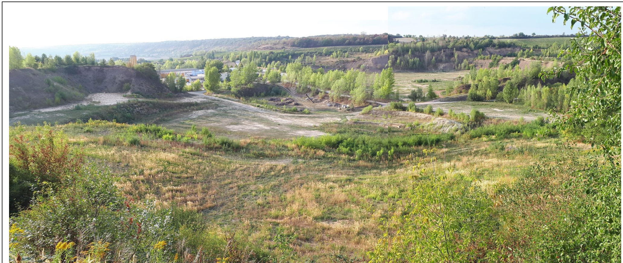
Bild 1: Übersichtsaufnahme von der Böschung der Altdeponie in Richtung Norden auf den Kiessandtagebau. Im Bildzentrum befinden sich die Flächen für die DK 0-Deponie, die sich bis zur Böschung auf der linken Bildseite erstreckt. Im Hintergrund sichtbar sind die Gebäude des Gewerbegebietes. In der rechten oberen Bildhälfte liegt die Fläche für die DK I-Deponie. Zwischen den beiden geplanten Deponieteilen verläuft die Zufahrtstraße (Betriebsstraße), umsäumt von Pappeln. 14.09.2018.
