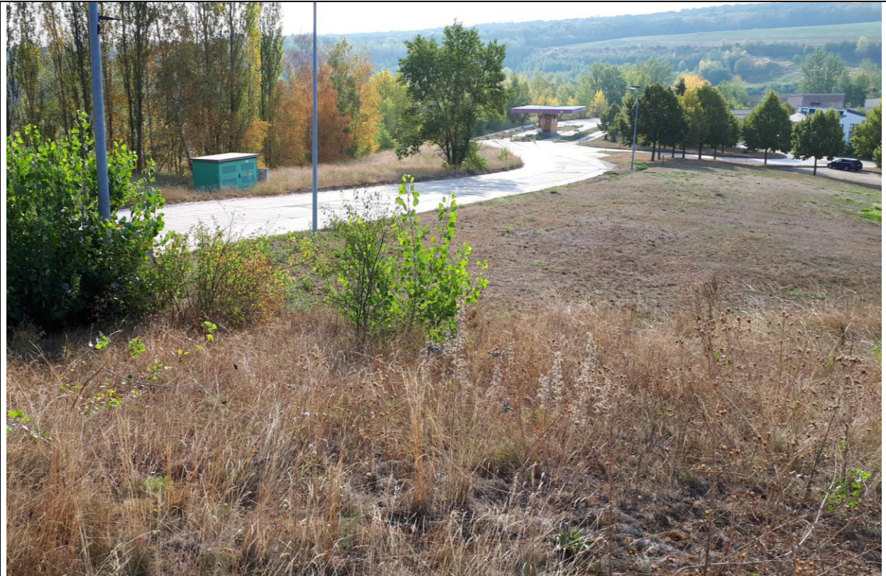
Bild 9: Eingangsbereich mit Zufahrtstraße (Betriebsstraße) zur geplanten Deponie und zum Gewerbegebiet. Links die Trafostation, in der Bildmitte die Waage und rechts hinter den Bäumen das Gewerbegebiet. Blickrichtung Südost, 28.08.2019
